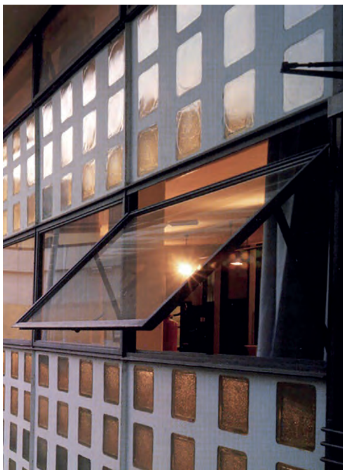
Ferrofinestra accostato a vetrocemento, Dispensario Antituberculare di Alessandria, Ignazio Gardella (foto di S. Di Resta, 2010)
