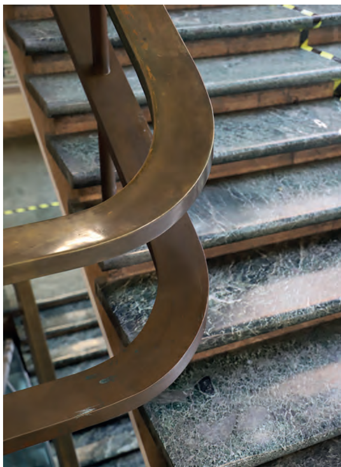
Ossidazione della ringhiera e della camicia in Similorlo nella Facoltà d'Ingegneria dell'Università di Bologna, Giuseppe Vaccaro (foto di M. Pretelli, 2020)
