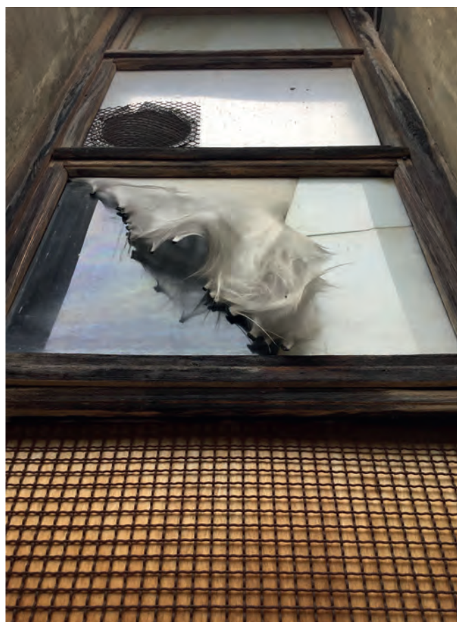
Fratturazione, mancanza e degradazione differenziale del Termolux, Istituto Tecnico Industriale di Forlì, Arnaldo Fuzzi (foto di G. Favaretto, 2018)
