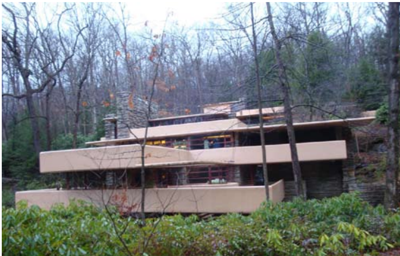
Casa Kaufmann, esterno. Foto arch. Corrado Scagliarini
