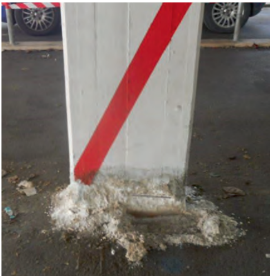
Foto 5 – Attacco solfatico della pasta cementizia
