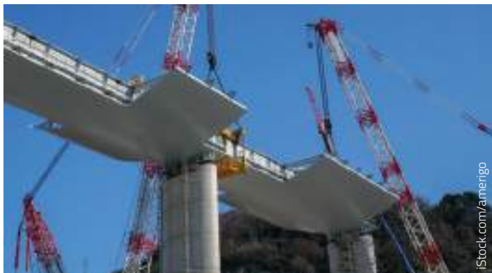
Costruzione del nuovo ponte sul fiume Polcevera
