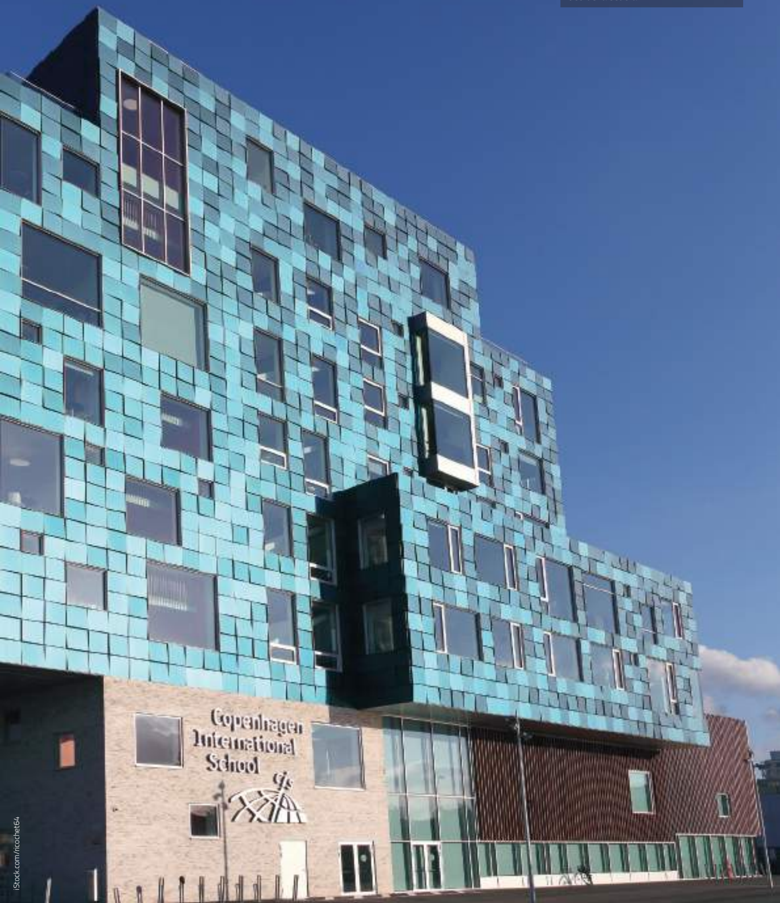
La Copenhagen International School (Danimarca). Le facciate sono coperte da piastrelle fotovoltaiche in grado di coprire la metà del fabbisogno energetico della scuola.
