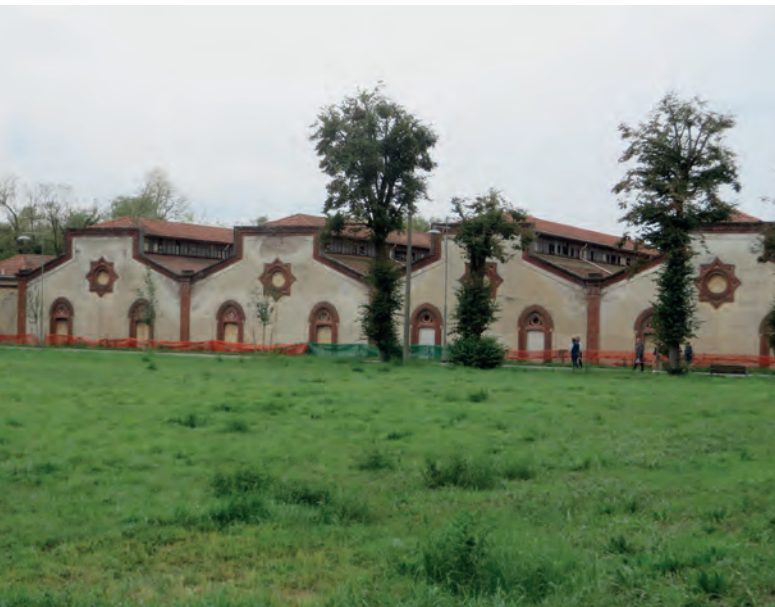
Fig. 7. Crespi d'Adda, la fabbrica, particolare edifici con copertura a shed
