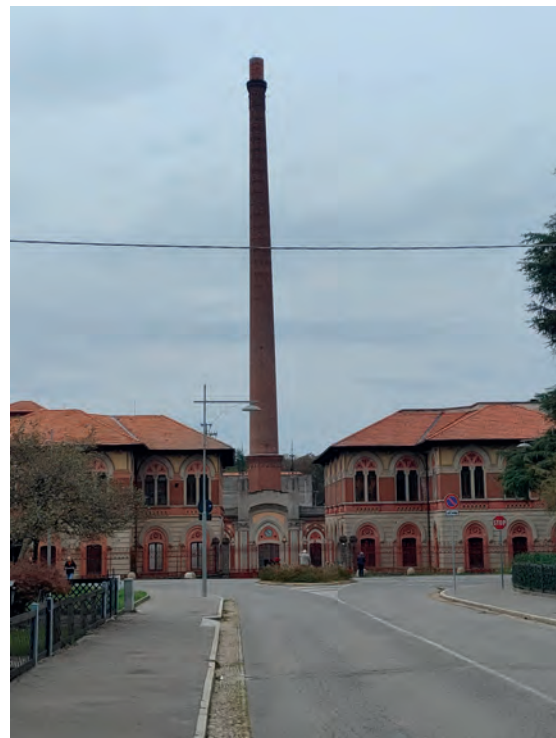
Fig. 6. Crespi d'Adda, la ciminiera della centrale termica
