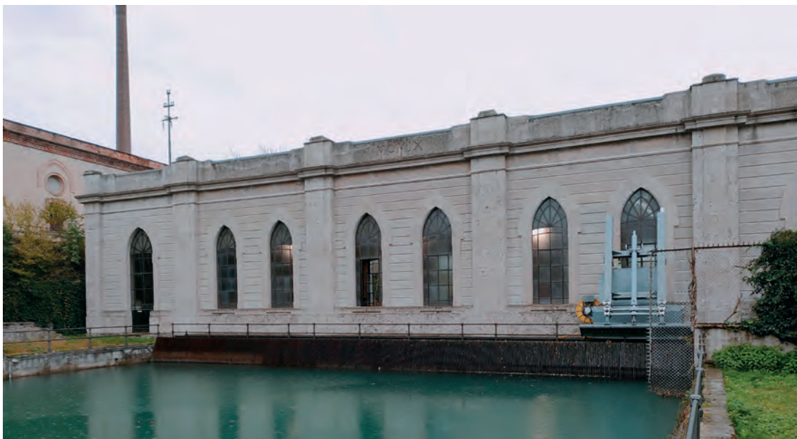
Fig. 15. Crespi d'Adda, centrale idroelettrica restaurata, particolare con sgrigliatore
