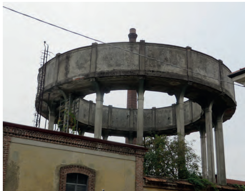
Fig. 10. Crespi d'Adda, serbatoio sopraelevato per acqua a corona circolare
